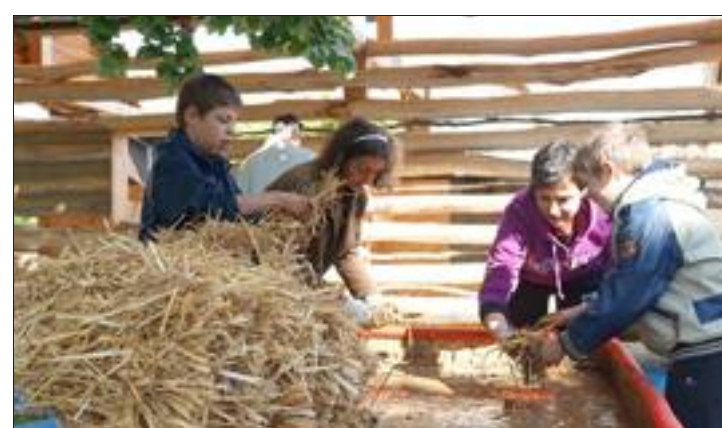
Paille et argile locales pour fabriquer le torchis, lors des chantiers participatifs qui ont rassemblé une quinzaine de bénévoles. DR
