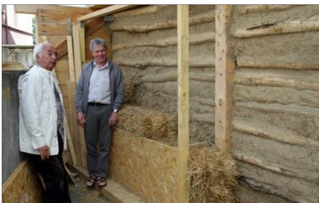
Marc Grodwohl (à gauche) avec le maire d'Ungersheim, Jean-Claude Mensch, devant le mur prototype de la future ferme du Kohlacker : des rondins de robinier et du torchis à l'extérieur, des bottes de paille pour l'isolation, qui viendront doubler les parois intérieures à ossature bois.
